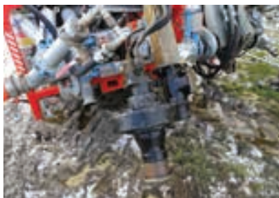
Στην αντλία πλήρωσης δεν υπάρχει πρόβλημα προετοιμασίας. Βγαίνει περισσότερη λάσπη από βαθύτερες λιμνοδεξαμενές.
