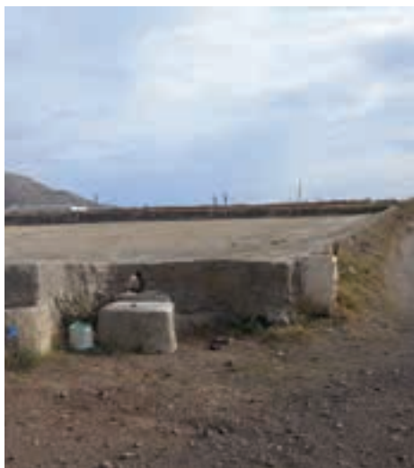
Στέρνες με τσιμέντινη λεκάνη απορροής κατασκευασμένες μέσα στα χωράφια αποκαλύπτουν την προσπάθεια του ανθρώπου στα νησιά να συλλέξει το νερό της βροχής.
